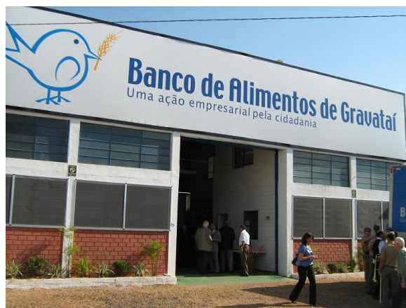
Fachada do novo Banco de Alimentos de Gravataí.
