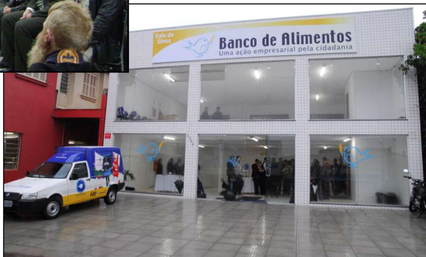
Instalações do Banco de Alimentos Vale do Sinos, tem capacidade para armazenar 400 Ton/dia; e está localizada a margem da BR116 em São Leopoldo.
